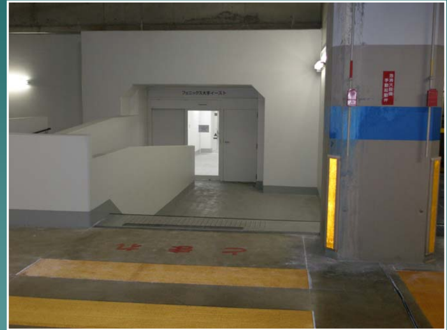
【地下駐車場⇒C棟】
