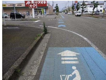
写真 ブルーラインの設置例
