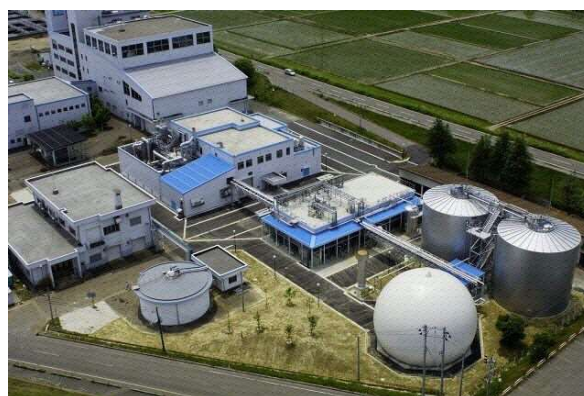
写真 生ごみバイオガス発電センター
