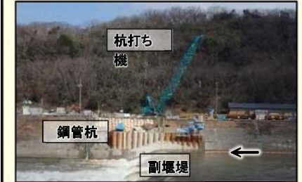
取付擁壁(鋼管杭)の打ち込む様子
