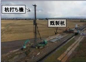
用水路の基礎部に杭を打ち込む様子
