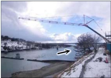
副堰堤下流の水上で地質調査を実施
