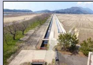
用水路付替後の状況
