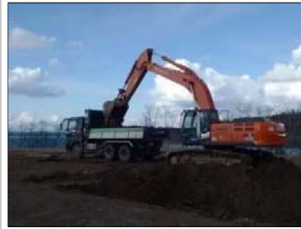
工事用道路工事の盛土材を河口部左岸より掘削土搬出
