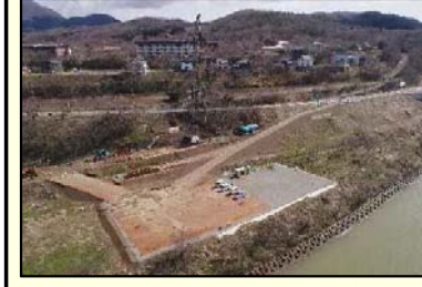
新野積橋右岸橋台の整備状況
