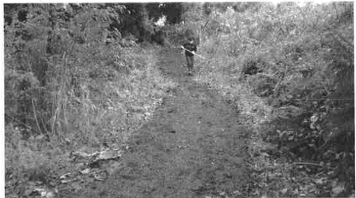
整地・ウッドチップ敷き完了
