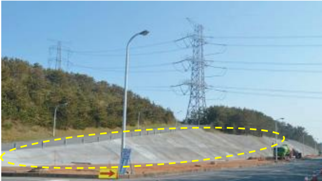
防火帯（灰色のモルタル部分）
