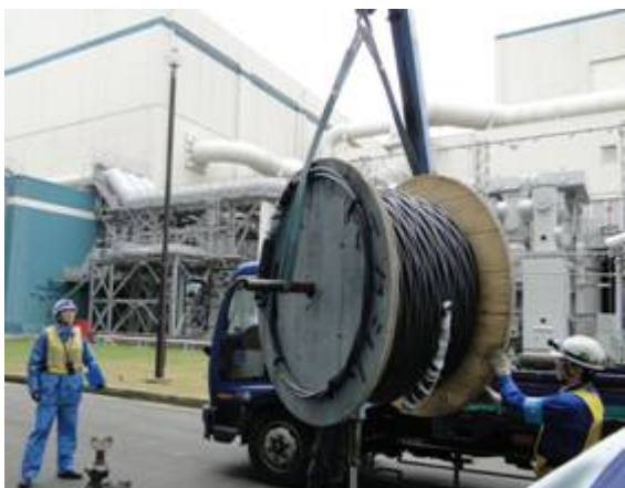
仮設ケーブルの準備
