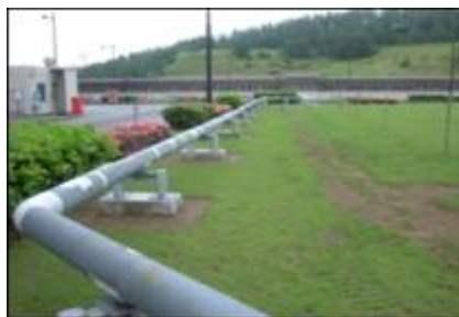
埋設消火配管の地上化 (総長9000m)
