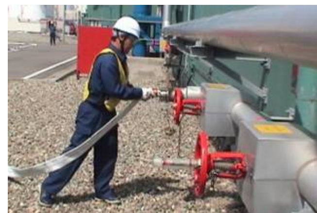
消防ホースの注水ライン接続
