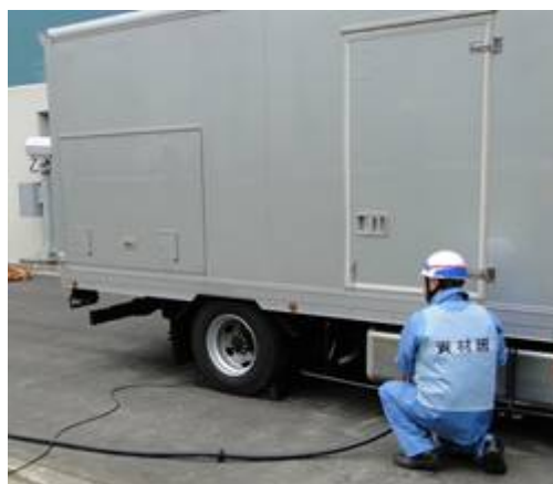
電源車へのケーブル接続
