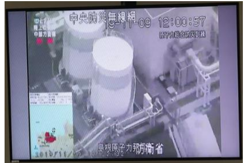
島根原子力発電所状況
