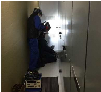
<接地線導通確認の様子>
