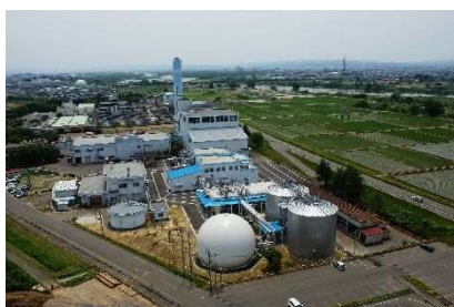
生ごみバイオガス発電センター
