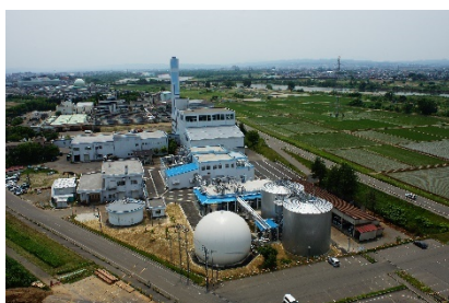
生ごみバイオガス発電センター
