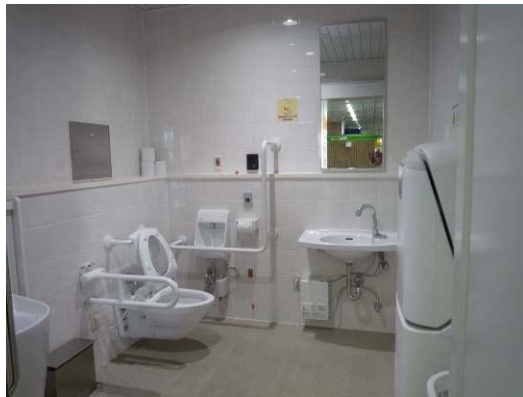
長岡駅新幹線改札内多機能トイレ
