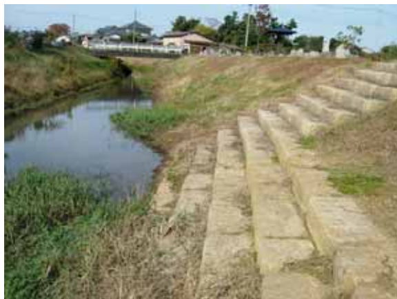
石段を設置して親水性を向上させた排水路
