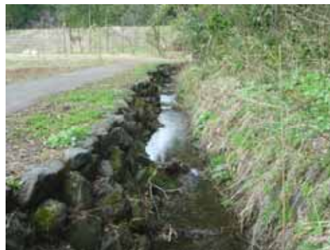
片側を石積みにした水路
