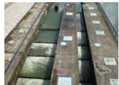
妙見堰の魚道
