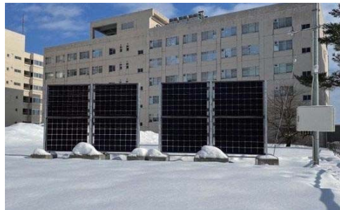
雪国対応の垂直両面受光パネル（長岡技術科学大学）
