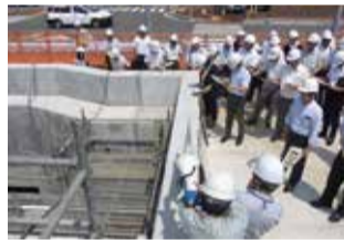
建設中の柿川放水路で事業の説明を聞く委員
