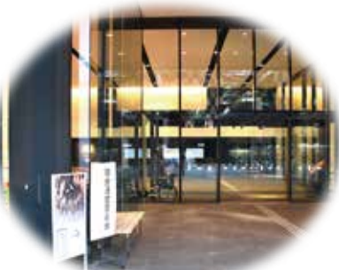
① アオーレ長岡西棟1階入口
