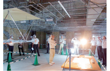
さいわいプラザ（仮称）改修工事現場
