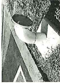
▲ 排水ポンプとホースをつなぐための立ち上げ栓
