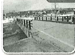
▲地域の悲願 犬茂大橋完成
