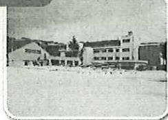
▲岡南中学校 大規模改修
