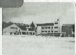
▲岡南中学校 大規模改修
