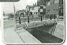
▲災害を防ぐ 天神橋架け替え完了
