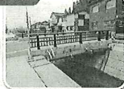
▲災害を防ぐ 天神橋架け替え完了
