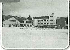
▲岡南中学校 大規模改修
