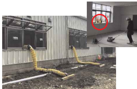
送風機を稼働し、埃を外部へ排出
