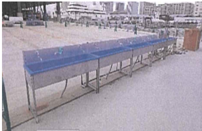
現場の手洗い場所の増設
