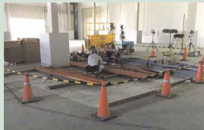
工事エリアの区画を設定して作業
