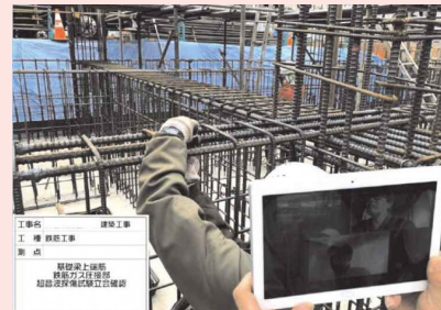
Webカメラを利用した遠隔検査
