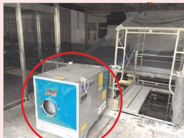
集塵機を設置し室内の換気を実施
