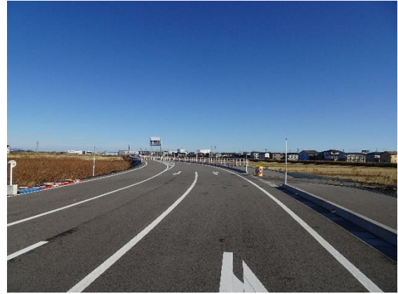
📷②：長岡北スマート IC 方向を望む (令和6年1月5日撮影)
