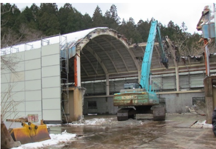
かいたいこうじ 解体工事の様子
