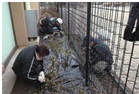
防草シート設置作業
