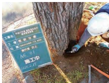
根幹治療：腐朽菌防止作業
