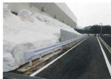
西側通路(落雪溝)
