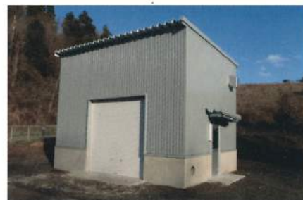
処理水調整施設
