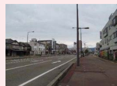
電線類が地中化された道路
