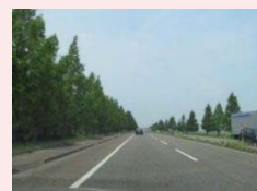
街路樹が連続した広域幹線道路
