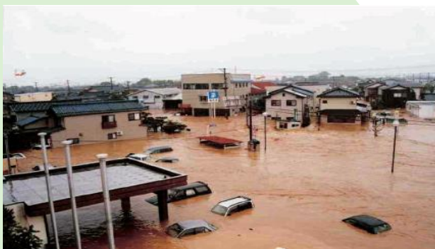
「平成16年7月新潟・福島豪雨」による 洪水被害の状況(中之島地域)
