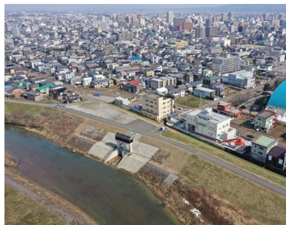
図 2-2-7 ≪柿川放水路 (2019 年竣工)≫ (出典:長岡市)
