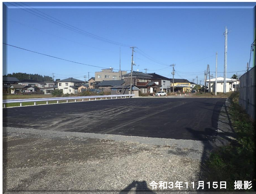
工事進捗 (西側 バス回転場)
