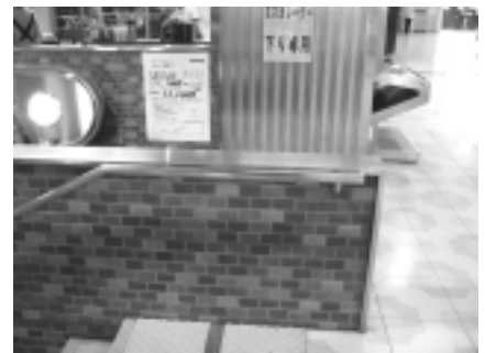
改札外の階段の手すり 改札外の手すりに点字による案内がない。
