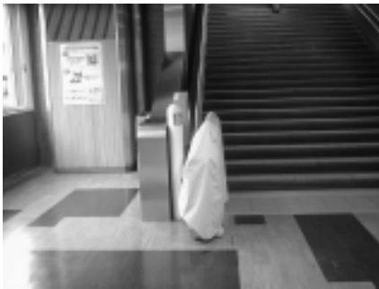
新幹線ホーム階段の昇降機 ホームまではエレベーターではなくリフトによる昇降となる。なお、別経路で業務用エレベーターが利用できる。
