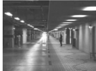
大手通地下駐車場（通路）
