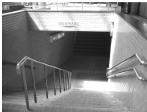
長岡駅地下通路（出入口部）
