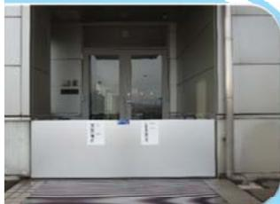
降雨前に建物や敷地の出入口に設置することで、家屋への水の浸入を防ぎます。浸水に耐える材質で、取りはずし又は移動が可能な設備が対象です。
