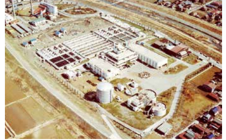
昭和51年に供用開始した第一下水処理場(現長岡中央浄化センター)全景
