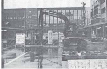
昭和55～58年の大手通りにおける下水道工事
