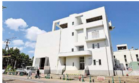
浸水対策として寿町排水ポンプ場建設
