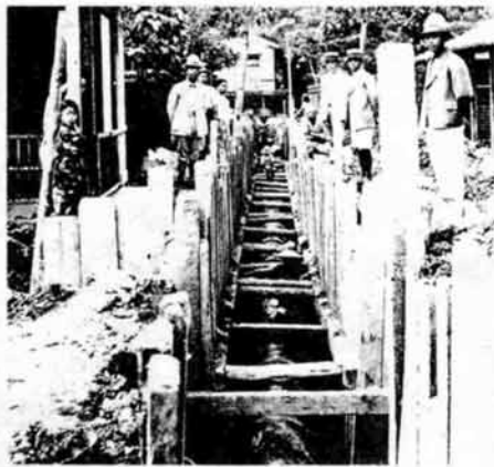
▼文治での下水管の布設工事。写真の右端が高崎隆次郎さん。
