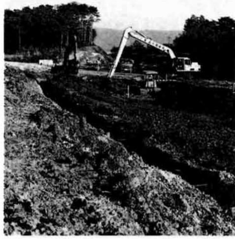
ニュータウン中央線工事（田宮病院裏）
