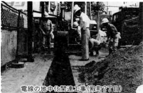
電線の地中化関連工事(殿町2丁目)
