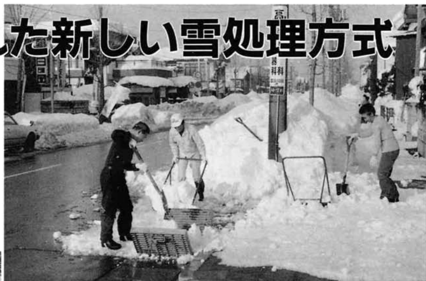
▶住民の力が何より大切な流雪溝による雪処理(土合) (宮本東方町の流雪溝)
