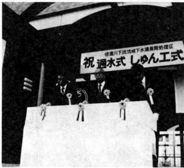
▲長岡浄化センター(流域下水道)運転始まる
