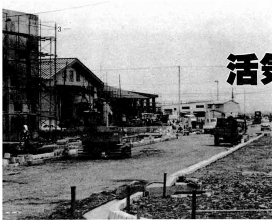
進出企業の建設が本格化する新産業センター
