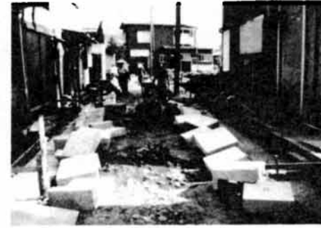
生活道路の整備 8億7163万円 舗装延長…36,626メートル 改良延長…7,248メートル
