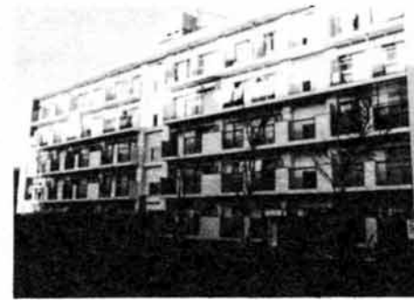
市営住宅の建設 3億2691万円 宮栄団地に鉄筋コンクリート造り2棟、54戸の住宅を建設
