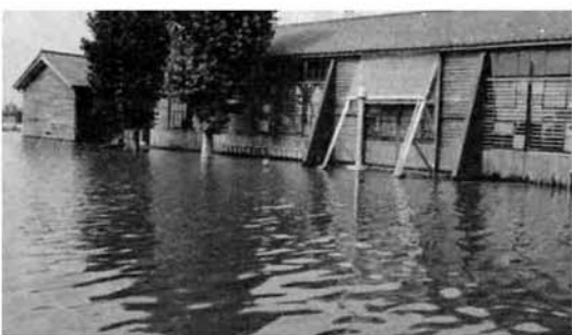
床上浸水の新組小学校
