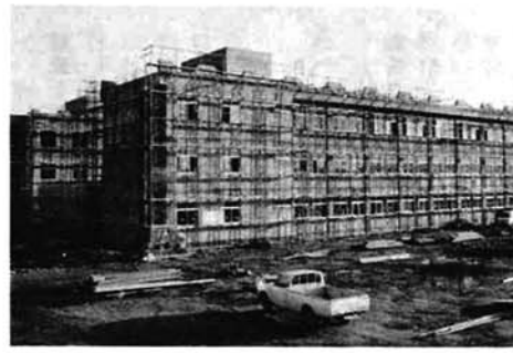
進む学校建設工事
