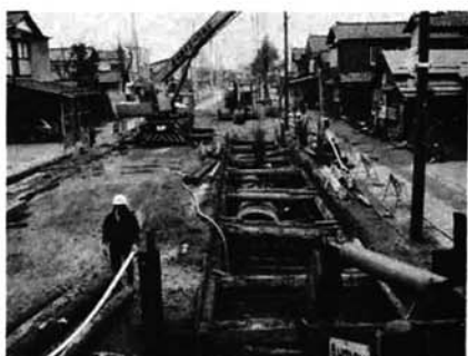
急ピッチで進む下水道工事
