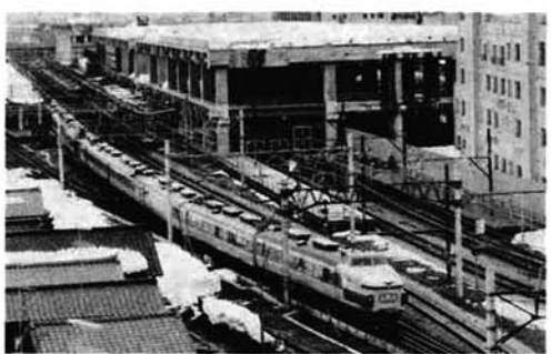
長岡駅舎改修工事
