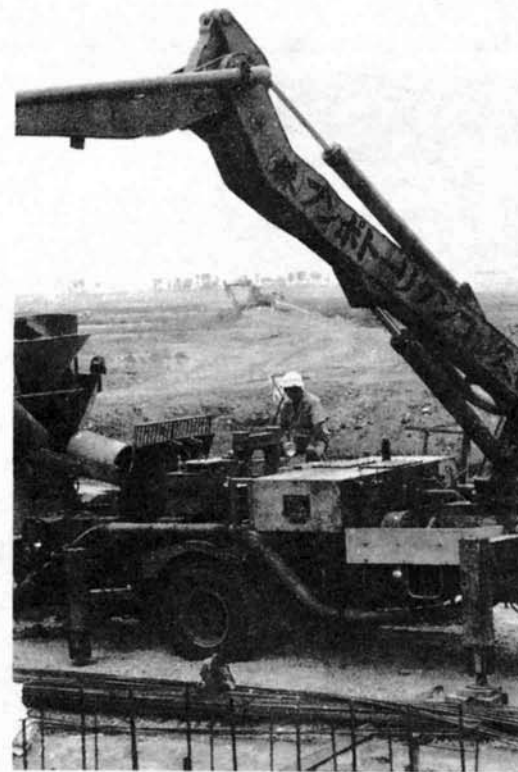
進む長岡東バイパス工事 市街地の交通渋滞の解消が期待される東バイパス。撤入式が行われ本格的な工事が始まりました(10.22)
