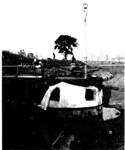
第7期拡張事業で大いに活躍が期待される取水施設(大島地区)
