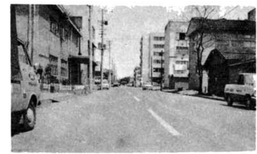
整備される市道
