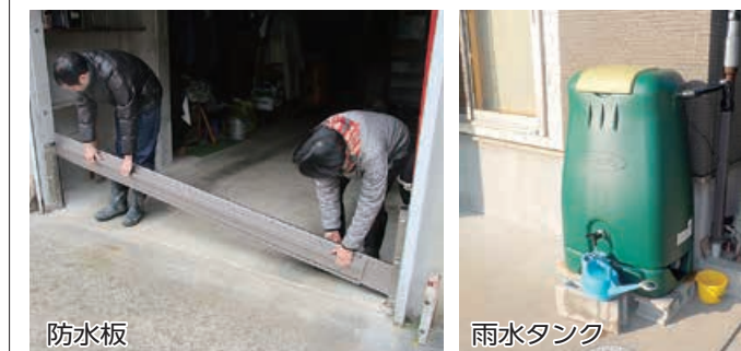
防水板 雨水タンク
