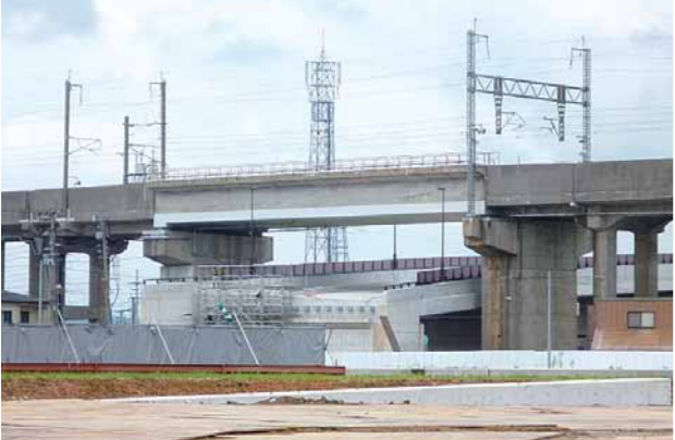
▲工事が進む榎山町亀貝線の稲葉立体交差
