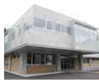
▲完成した深オコミュニティセンター
