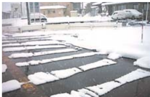
▲写真は適正な散水量によって消雪した路面 ルール案①の基準には、散水量の目安として、道路ではおおむね0.3ℓ/m 2 ・分、散水幅は、おおむね20cm以下などの具体的な数値情報を盛り込む予定です。
