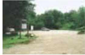
▲完成した駐車場
