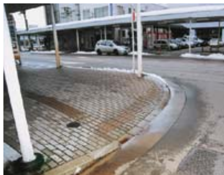
段差を解消した歩道（表町2丁目）
