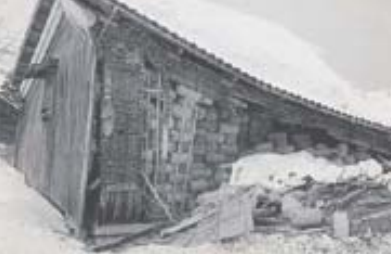
昭和36年2月に起きた長岡地震で倒壊した建物。この地震での死者は35人、住宅の全壊220戸を含む家屋破壊は1,571戸にのぼりました。
