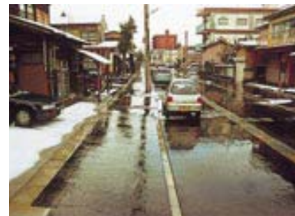
昨年、柏町1丁目と千手2丁目の境界の市 道に設置したバリアフリー道路 歩道を最優先に融雪して、雪のない安全・ 快適な歩道を提供します。
