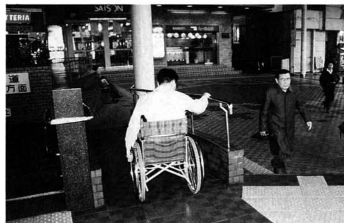
▼両側に手すりのついた長岡駅前のスロープ（斜路）。スロープがあれば、段差のある所も車いすで通行できます。
