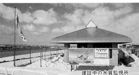
建設中の水質監視所
