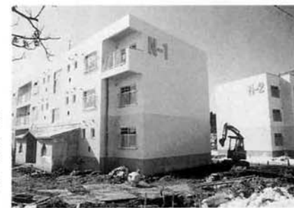
▶第1期工事では、市営住宅2棟・18戸を建て替えました。
