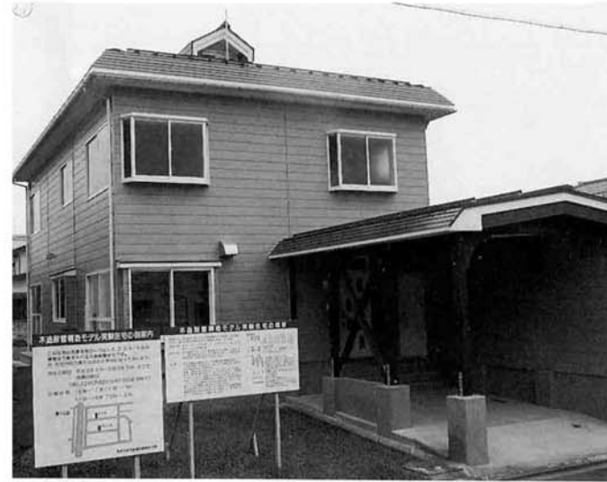
▲東新町1丁目の木造耐雪構造モデル実験住宅
